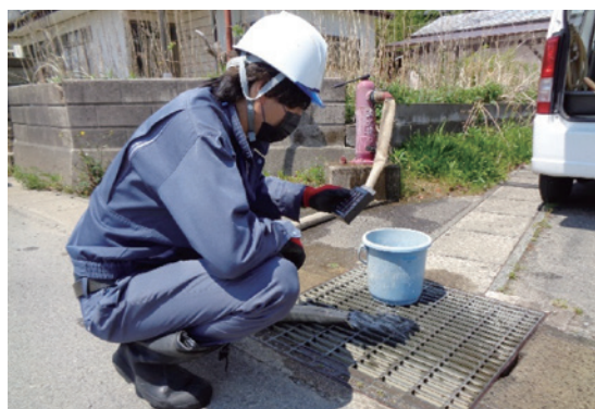
消火栓にて試験通水確認
