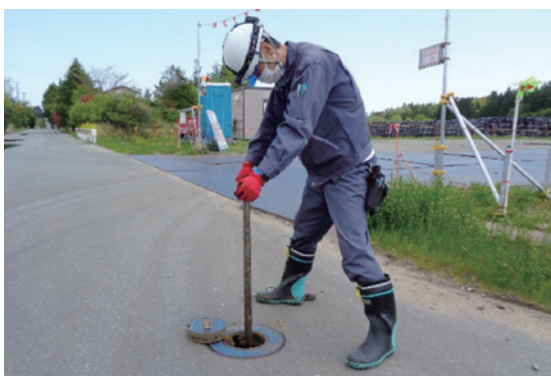
バルブ操作にて試験通水実施
